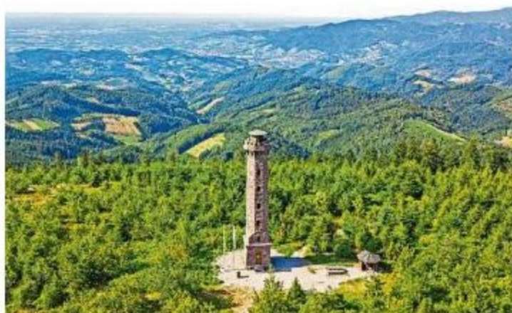
Der Moosturm, einer der ältesten Aussichtstürme des Schwarzwaldes, erbaut 1890, bietet eine Rundumsicht in die Täler des mittleren Schwarzwaldes und das Rheintal bis zu den Vogesen. Foto: Archiv
